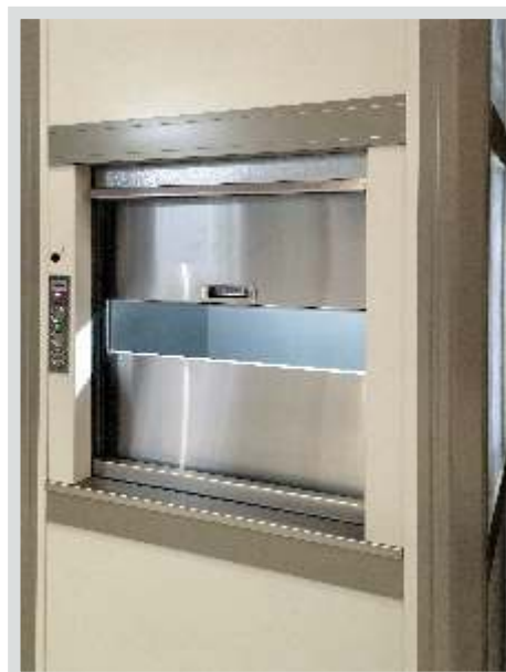
Алюминиевый металлокаркас с зашивкой листовой сталью с ТЛКП. Дверь шахты из нержавеющей стали, двери кабины - сталь нержавеющая шлифованная.
