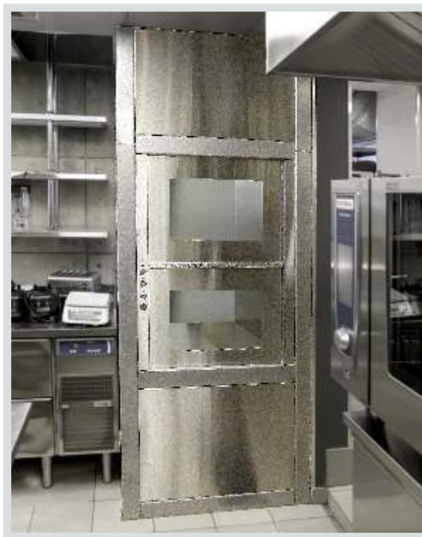
Стальной металлокаркас с зашивкой специальными щитами
