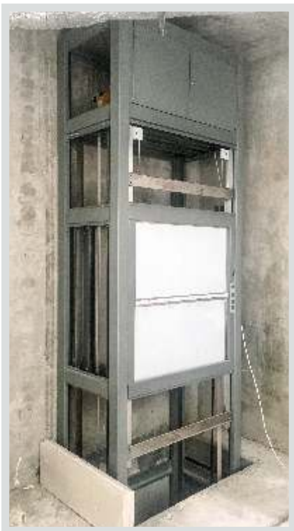
Стальной металлокаркас без зашивки
